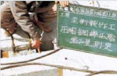
圧縮PC鋼材配置の短縮量測定
